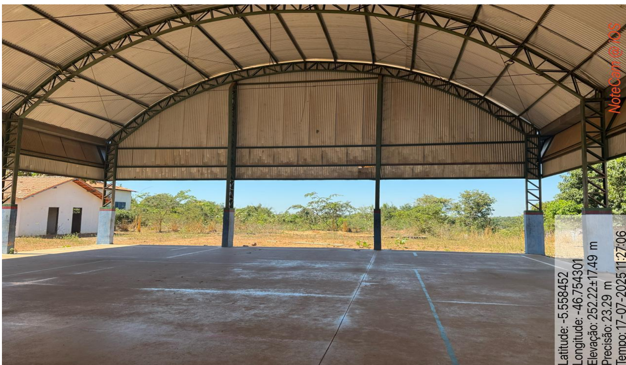
IMAGEM 02: EXECUÇÃO PINTURA DE PISO COM TINTA EPÓXI, APLICAÇÃO MANUAL.
