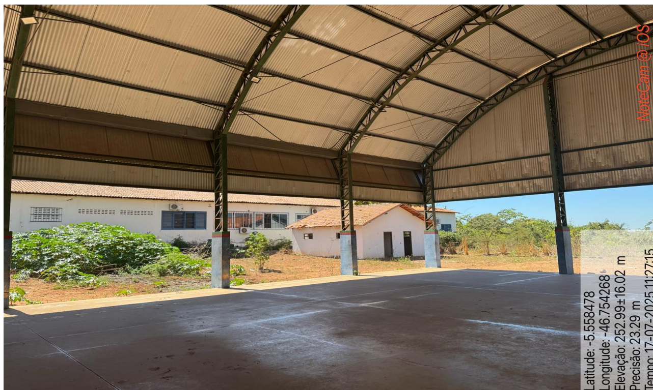
IMAGEM 03: 30 % DE TELHAMENTO COM TELHA METÁLICA EM CHAPA DE AÇO GALVANIZADO NATURAL ONDULADA E=0,5MM E 10% RECUPERAÇÃO DE ESTRUTURA METÁLICA.
