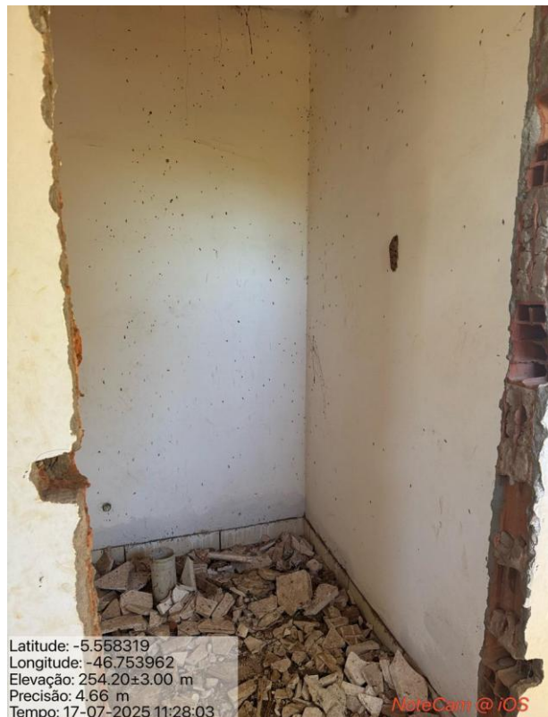
IMAGEM 06 E 07: RECUPERAÇÃO DOS BANHEIROS COM NOVA PINTURA, REMOÇÃO DE ENTULHO, INSTALAÇÃO DE PEÇAS E ACESSÓRIOS, NOVO REVESTIMENTO E PISO CERÂMICO.
