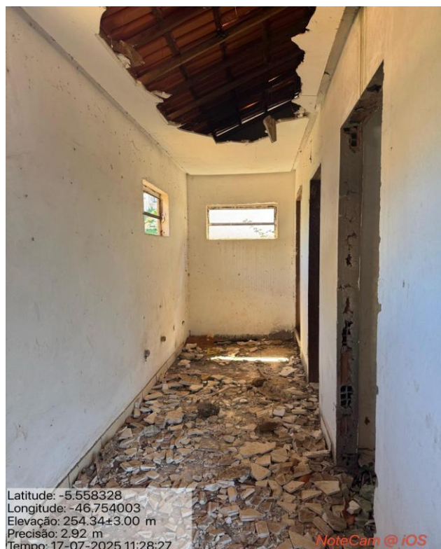
IMAGEM 05: REMOÇÃO DE FORRO, TROCA DE ESQUADRIAS, RETALHAMENTO E INSTALAÇÃO DE PORTAS.
