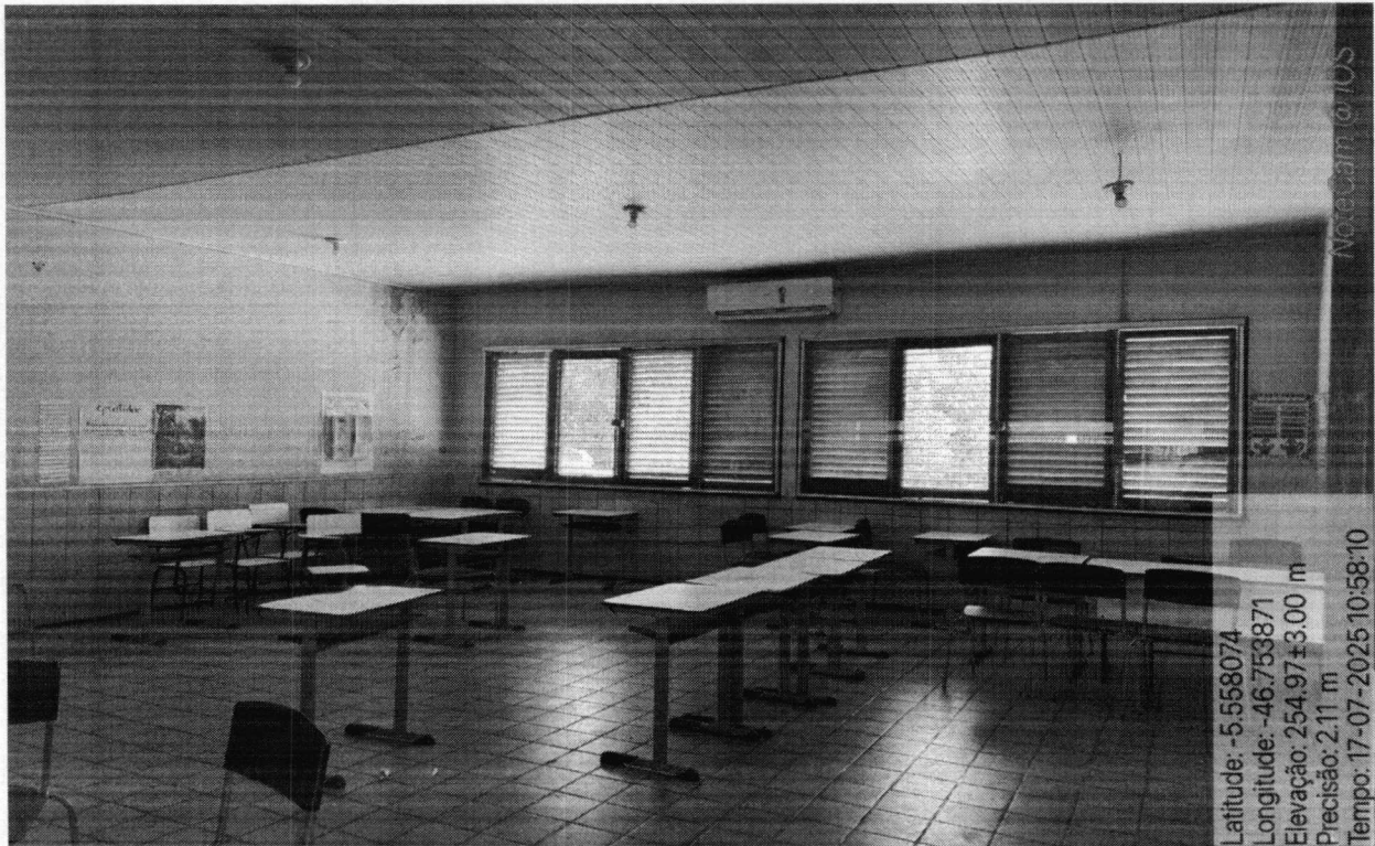
IMAGEM 05: Troca de piso cerâmico, fechamento das janelas de madeira e substituição do forro de PVC por forro em gesso.
