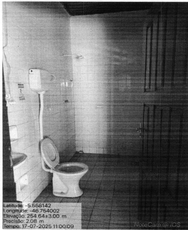
IMAGENS 09 e 10: Troca do revestimento cerâmico de todos os banheiros.
