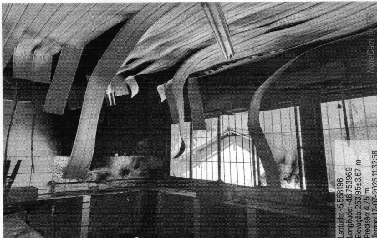
IMAGEM 15: Troca de forro PVC danificado por forro em gesso.
