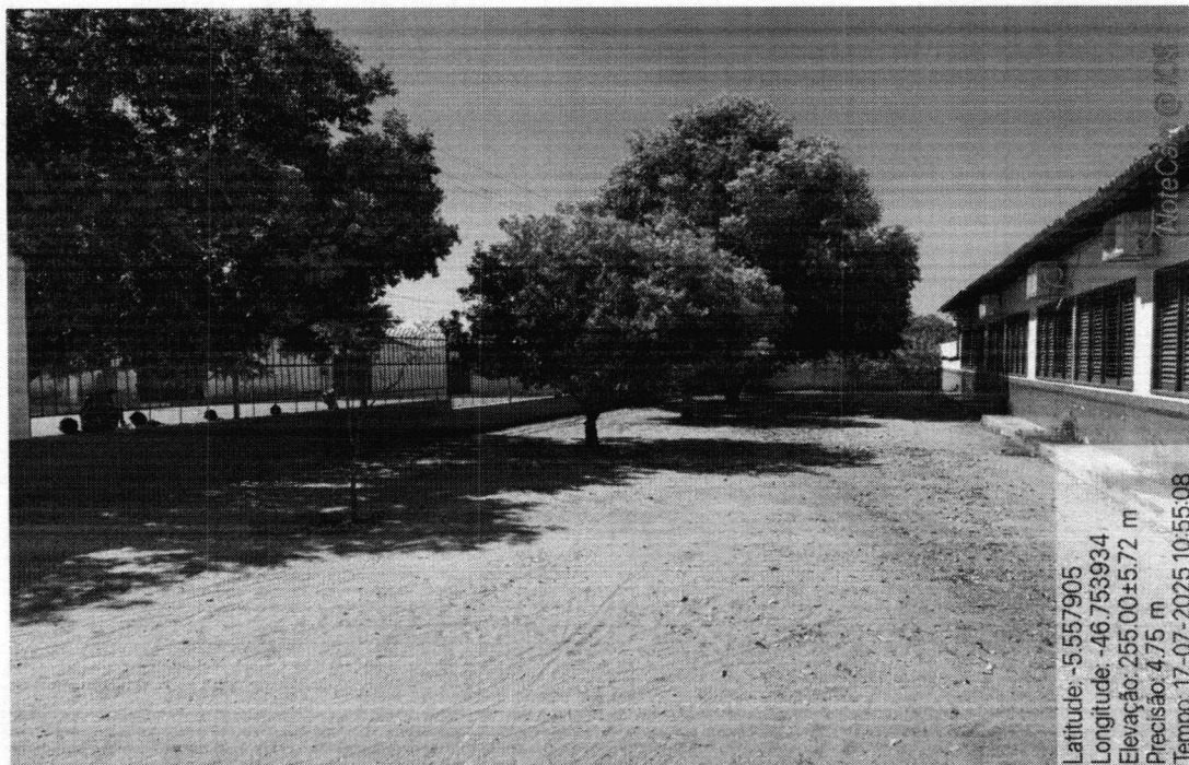
IMAGEM 01: Execução de pavimento rígido (bloquete), ampliação do muro para altura de 3,00 m.
