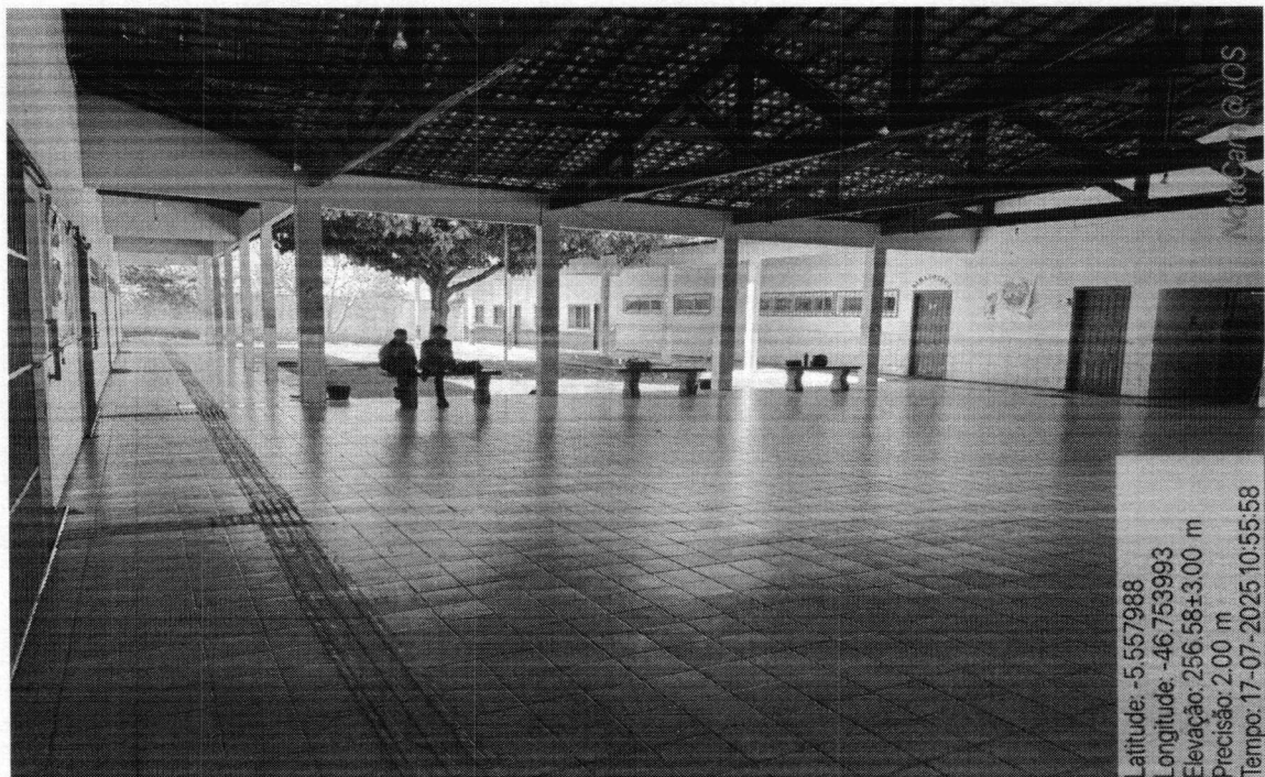
IMAGEM 03: Troca de todo o piso cerâmico da escola e retelamento com telha cerâmica tipo Plan.
