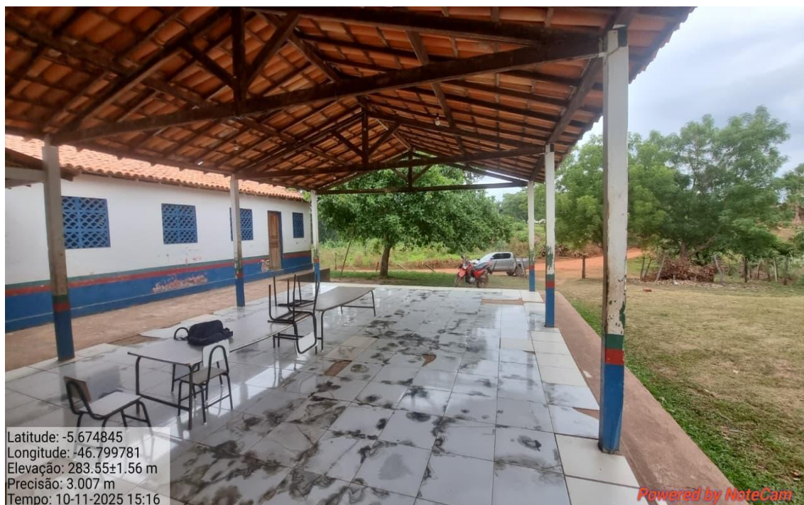
IMAGEM 02: TROCA DOS PILARES DE MADEIRA POR PILARES DE CONCRETO, RETELHAMENTO DE 100 % COM TELHA PLAN.
