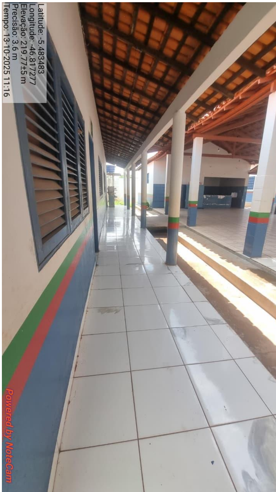
IMAGEM 15- ÁREA DE CIRCULAÇÃO COBERTA NO BLOCO 2 QUE SERÁ FEITO TROCA DE PISO, E TROCA DE JANELAS DE MADEIRA PO JANELAS DE ALUMÍNIO E VIDRO
