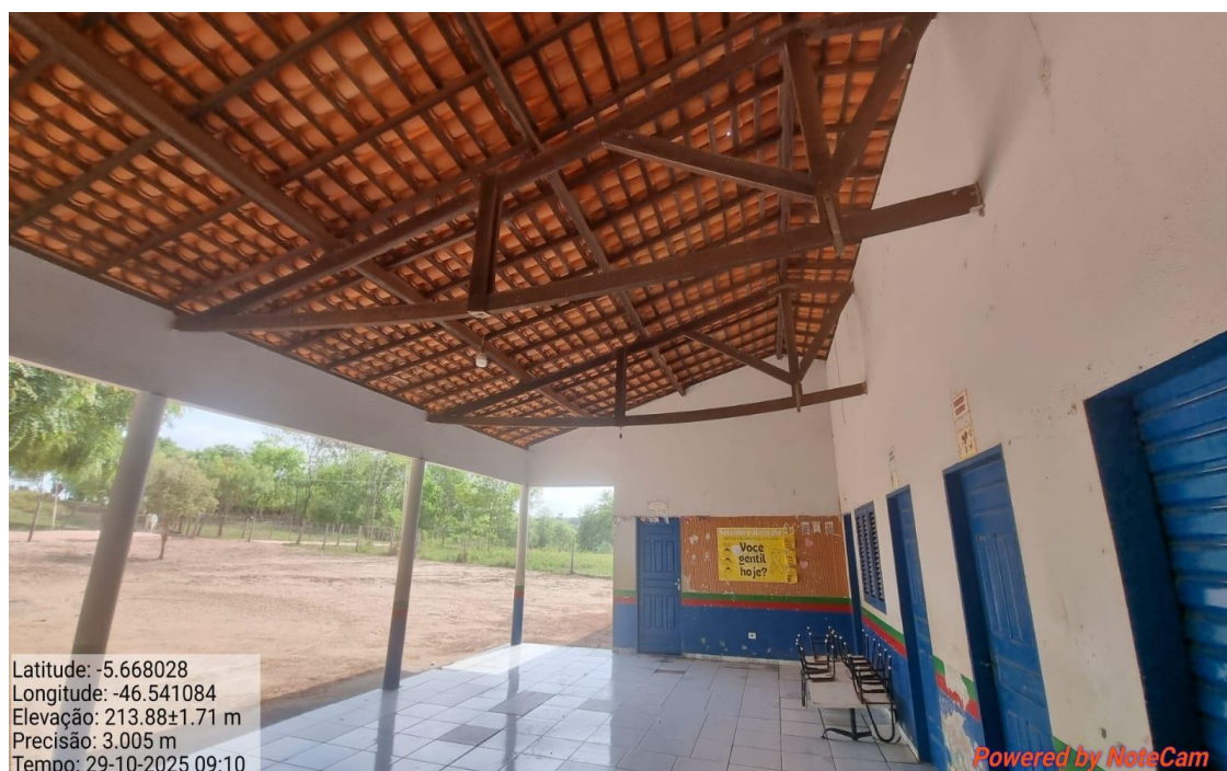
IMAGEM 05: TROCA DAS TESOURAS DE MADEIRA E RETELHAMENTO.
