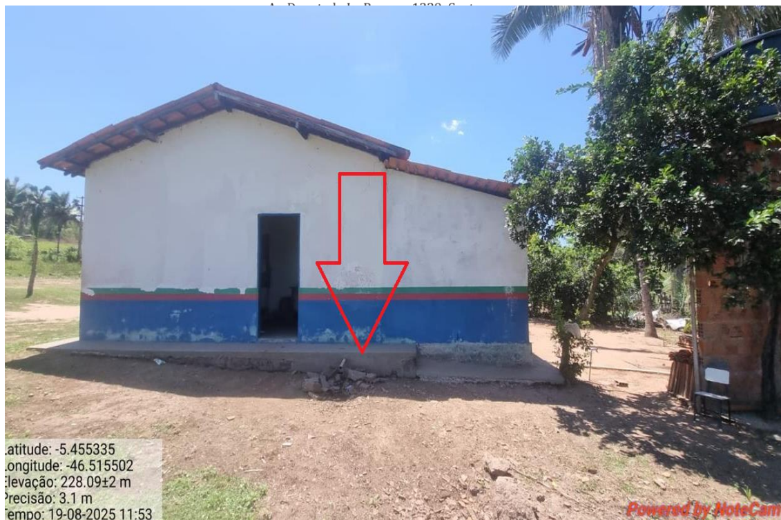
IMAGEM 07: FACHADA LATERAL DIREIRA ONDE SERÁ CONSTRUÍDO UMA SALA DE AULA.
