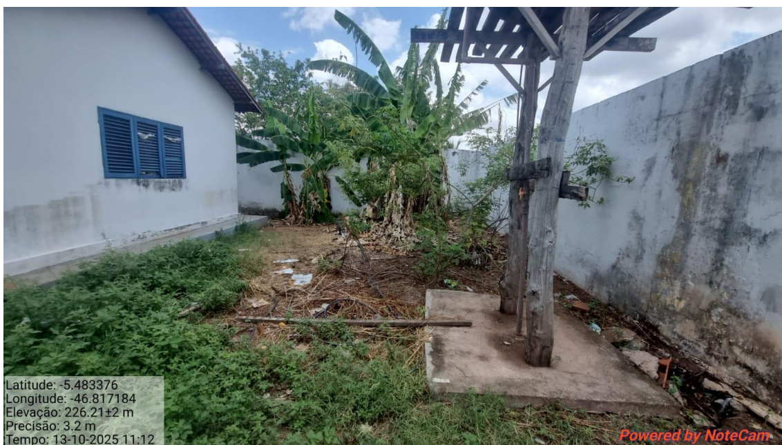
IMAGEM 7- ÁREA EXTERNA QUE SERÁ LIMPA, E CAIXA D'ÁGUA QUE SERÁ REFORMADA E PINTADA.
