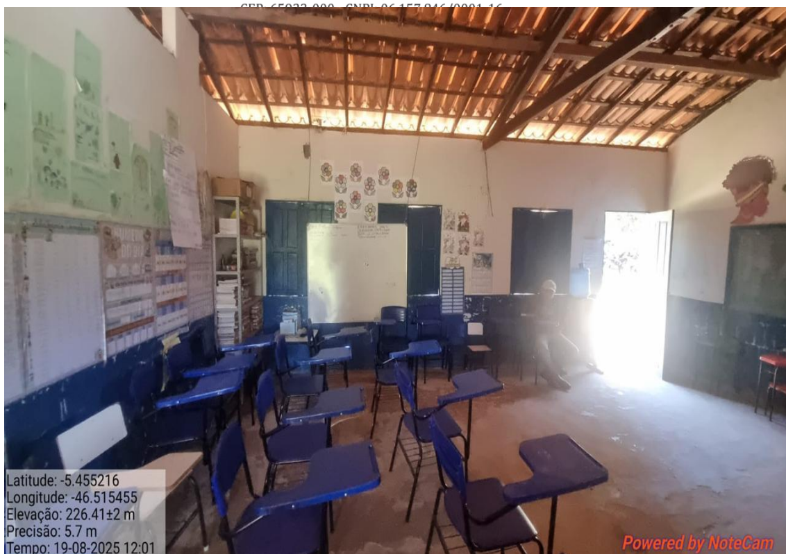
IMAGEM 05: SALA DE AULA 01, TROCA DE PISO, PINTURA, TROCA DE ESQUADRIAS, FORRO EM GESSO E RETELHAMENTO.
