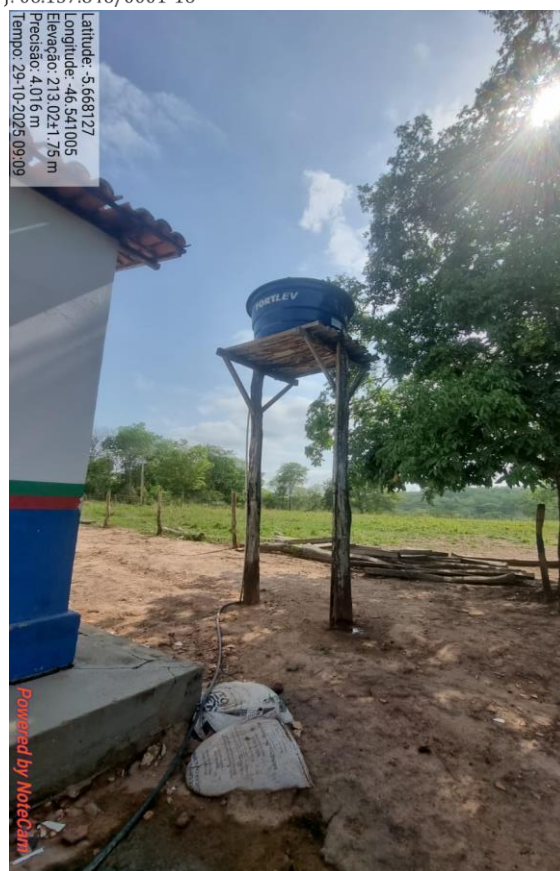
IMAGEM 04: TROCA DA ESTRUTURA DA CAIXA D'ÁGUA POR CONCRETO
