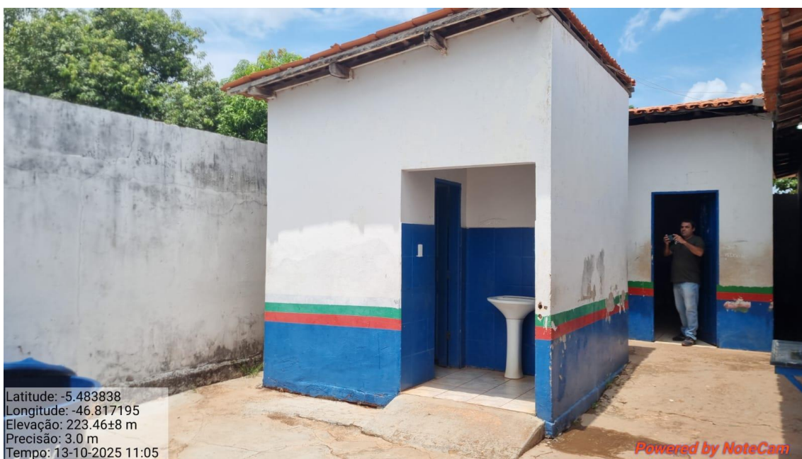
IMAGEM 17 - BANHEIRO QUE SERÁ DEMOLIDO E CONSTRUÍDO UM NOVO.
