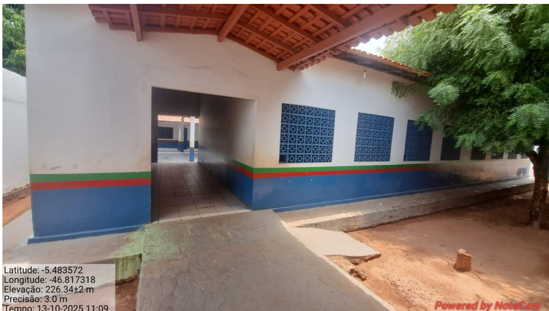
IMAGEM 6- ENTRADA AO BLOCO 2 ONDE QUE SERÁ REFORMADO COM JANELAS DE ALUMÍNI E VIDRO NO LUGAR DOS COBOGÓS.
