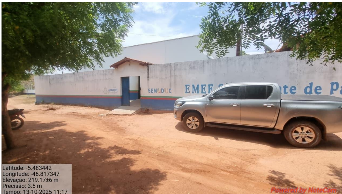
IMAGEM 16 - FACHADA FRONTAL DO BLOCO 1 QUE RECEBERÁ REFORMAS E AMPLIAÇÃO DOS BANHEIROS
