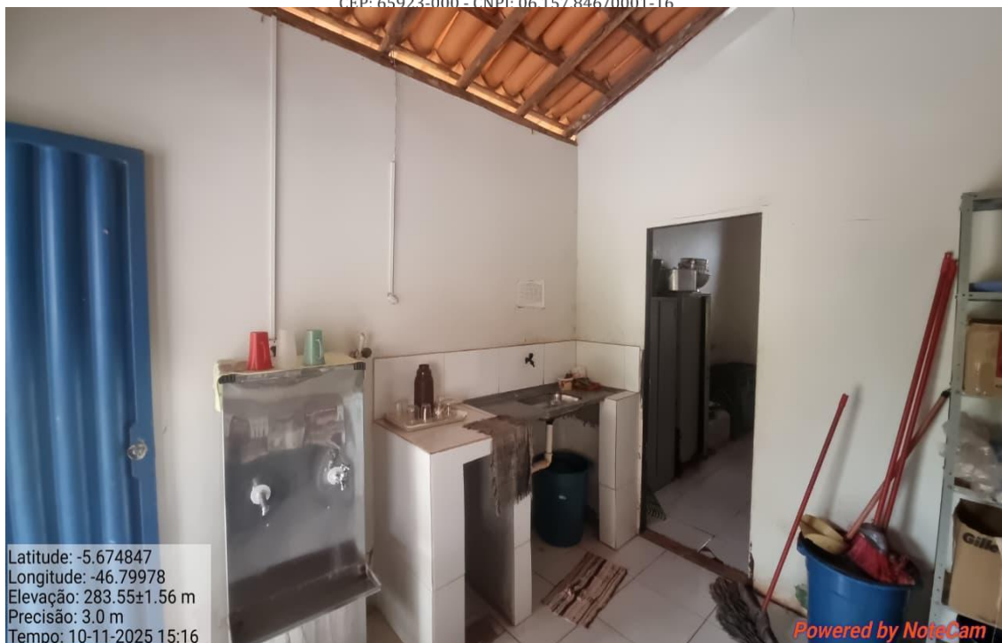
IMAGEM 12: REVESTIMENTO CERÂMICO PARA PAREDES INTERNAS COM PLACAS TIPO ESMALTADA EXTRA DE DIMENSÕES 33X45.
