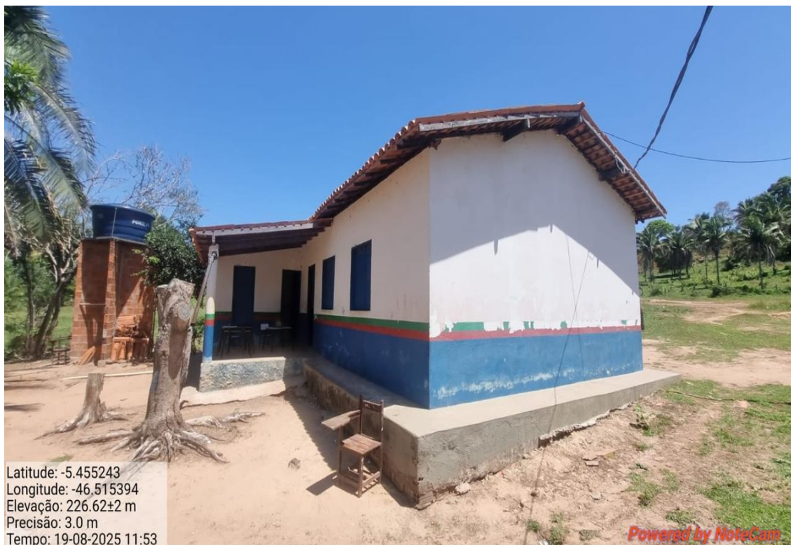
IMAGEM 04: FACHADA LATERAL ESQUERDA ONDE SERÁ CONSTRUÍDO NOVOS BANHEIROS.
