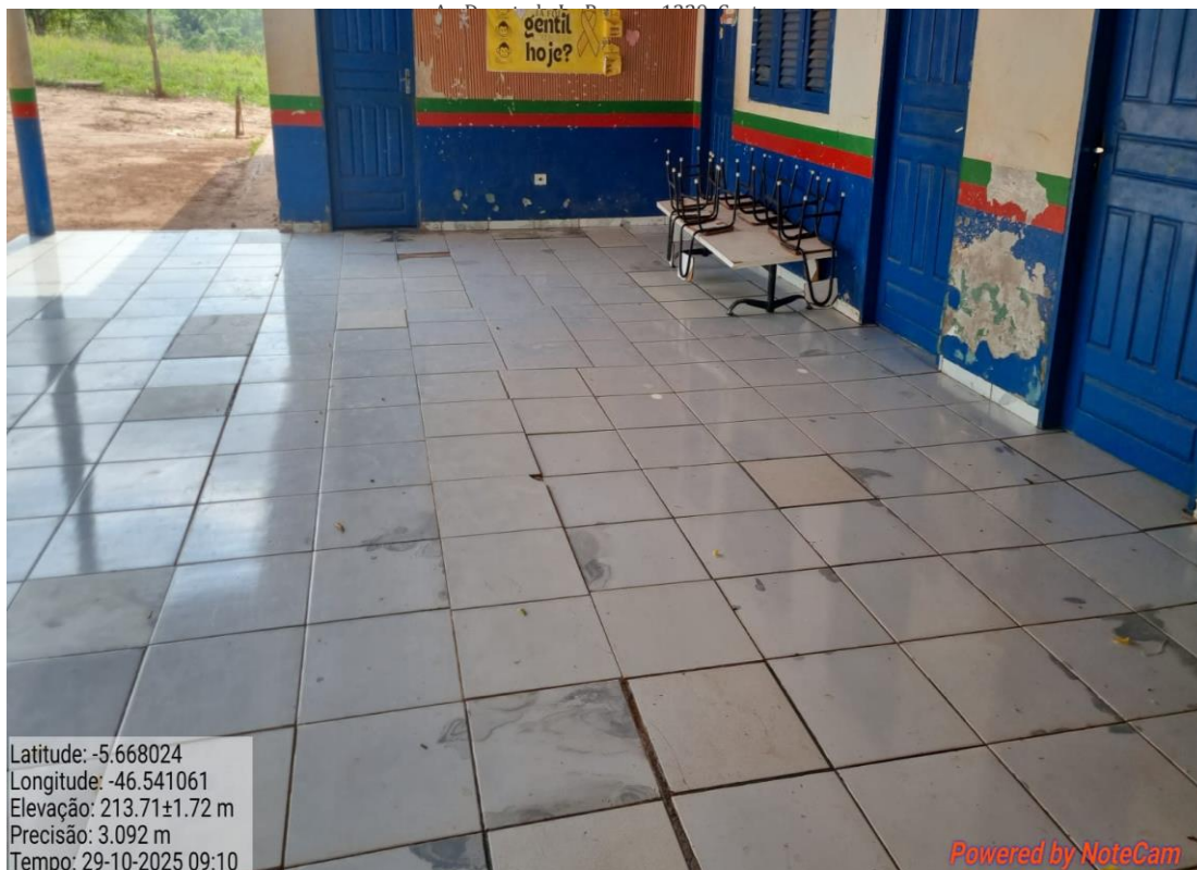
IMAGEM 06: TROCA DE TODO O PISO
