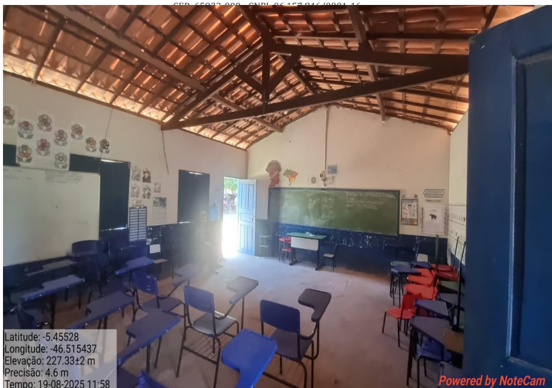
IMAGEM 03: SALA DE AULA 01, TROCA DE PISO, PINTURA, TROCA DE ESQUADRIAS, FORRO EM GESSO E RETELHAMENTO.
