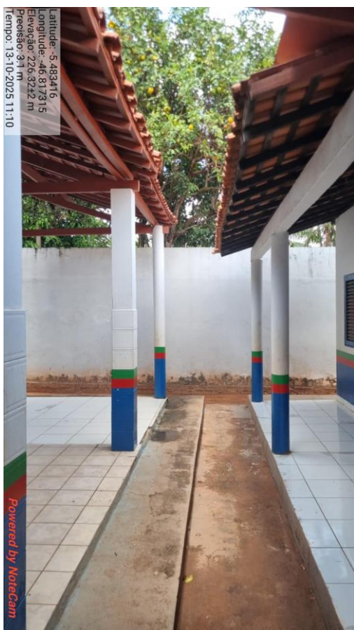
IMAGEM 4- PISO E TELHADO QUE SERÁ UNIFICADO
