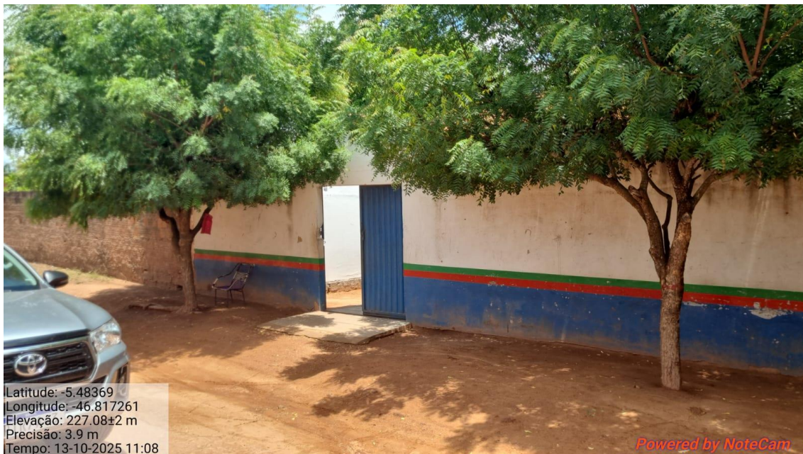
IMAGEM 1- FACHDA FRONTAL DO BLOCO 2 ONDE SERÁ REFORMADO OS BANHEIROS E ONDE SERÁ FEITO UNIFICAÇÃO DE PISO E TELHADO.
