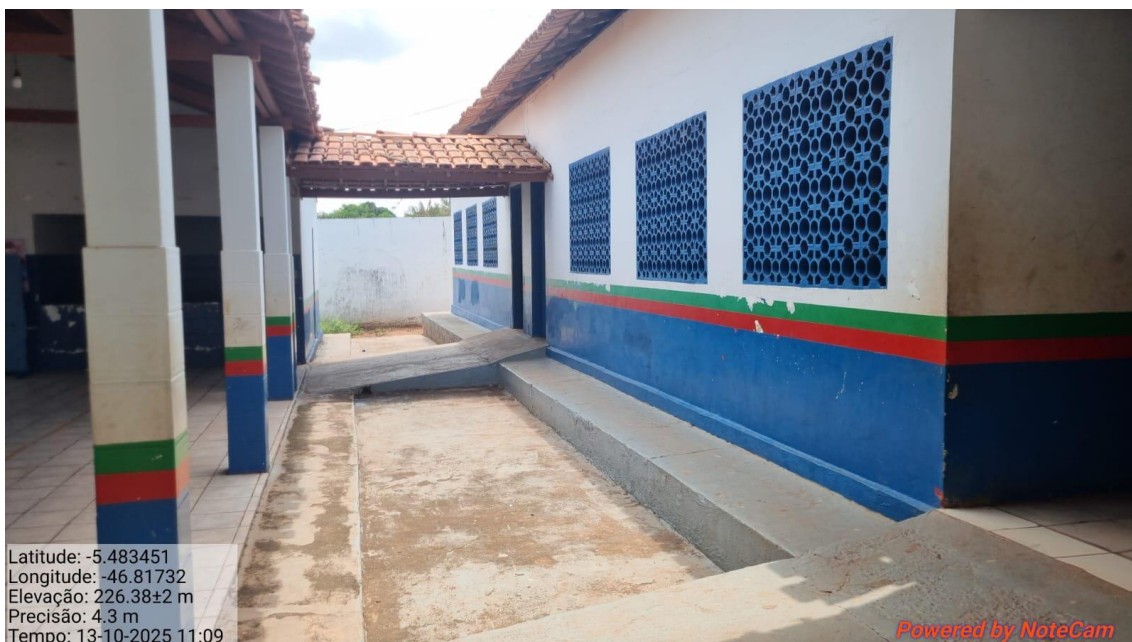
IMAGEM 3- CALÇADAS DE PROTEÇÃO DO BLOCO 2 QUE SERÁ REFORMADAS E PINTADAS
