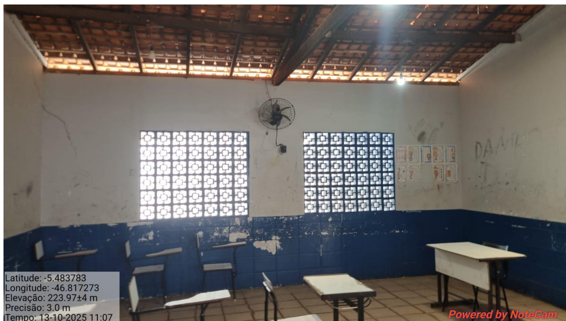
IMAGEM 27 - SALA DE AULA COM PISO, QUE RECEBERÁ NOVO PISO, NOVA JANELAS E FORRO DE GESSO
