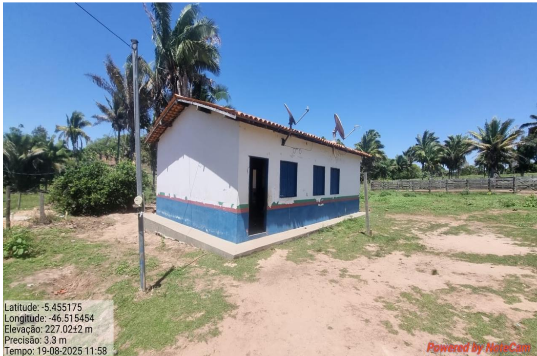
IMAGEM 01: FACHADA DA ESCOLA ONDE SERÁ REFORMA E AMPLIADA, COM CONSTRUÇÃO DE BANHEIROS, SALA DE AULA E VARANDA COBERTA.
