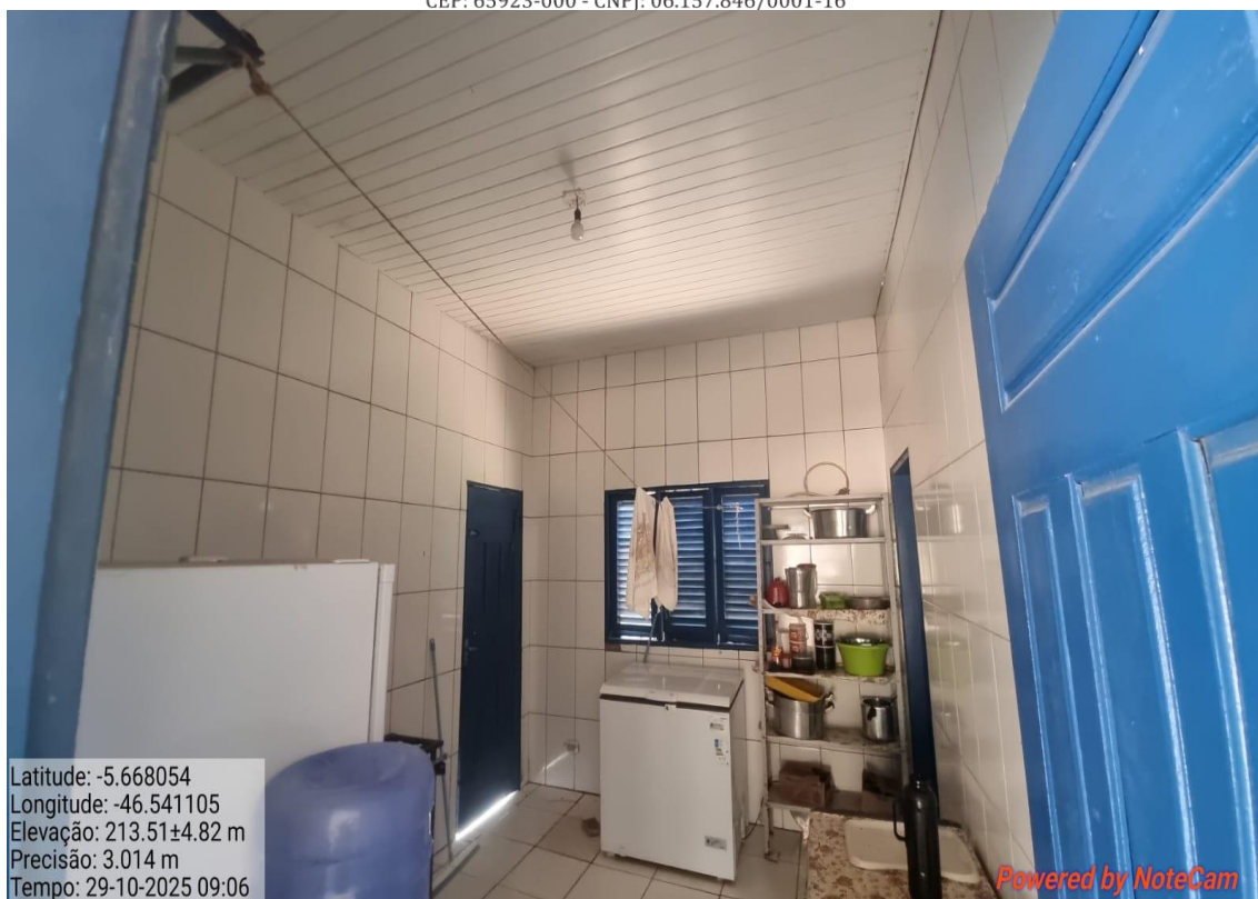
IMAGEM 07: MANUTENÇÃO DE FORRO DE PVC.
