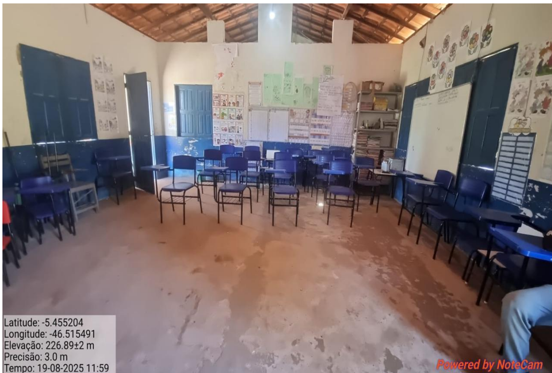
IMAGEM 06: SALA DE AULA 01, TROCA DE PISO, PINTURA, TROCA DE ESQUADRIAS, FORRO EM GESSO E RETELHAMENTO.
