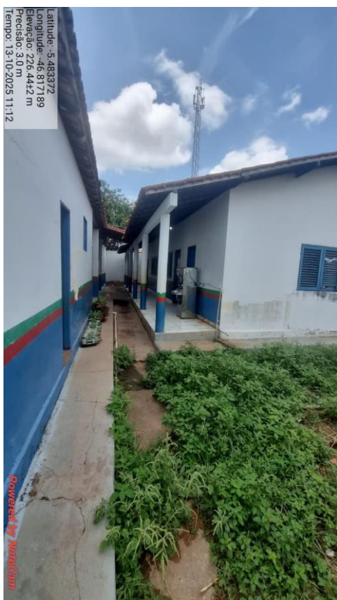
IMAGEM 9 – TELHADO QUE SERÁ UNIFICADO E ÁREA QUE SERÁ LIMPA
