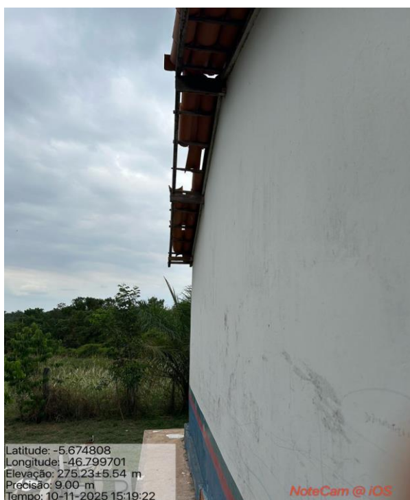
IMAGENS 07 E 08: TROCA DO TELHADO POR TELHA CERÂMICA CAPA-CANAL, TIPO PLAN.
