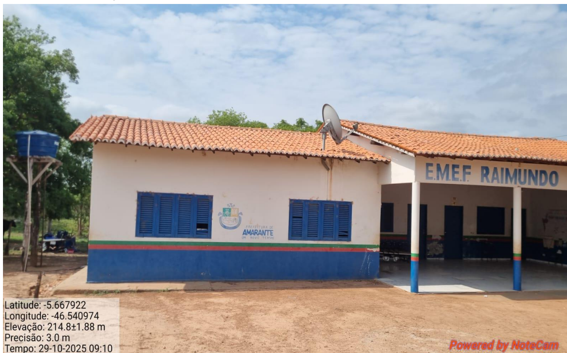
IMAGEM 02: SUBSTITUIÇÃO DE JANELAS DE MADEIRA POR JANELAS JANELA DE CORRER 4 FOLHAS EM ALUMÍNIO NATURAL COM VIDRO 6MM
