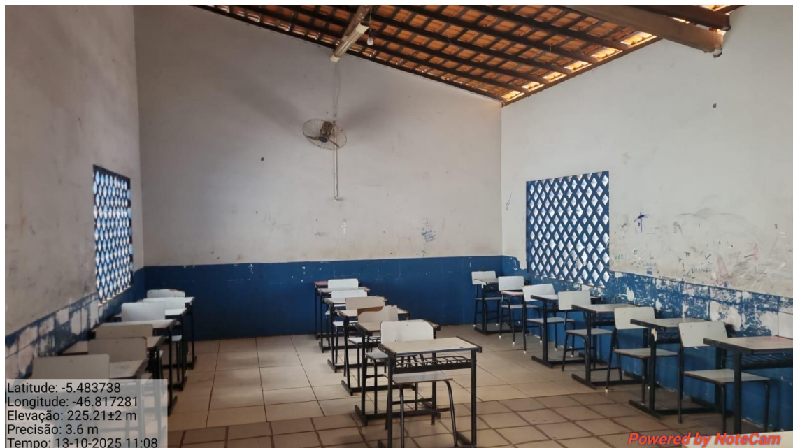
IMAGEM 25 - SALA DE AULA COM PISO, QUE RECEBERÁ NOVO PISO, NOVA JANELAS E FORRO DE GESSO.
