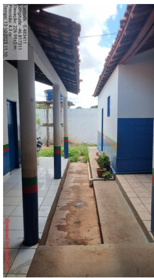
IMAGEM 5- PISO E TELHADO QUE SERÁ UNIFICADO
