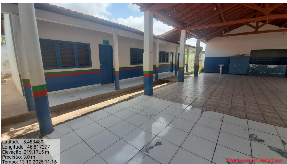
IMAGEM 14- PARTE DO PÁTIO MAIS ÁREA DE CIRCULAÇÃO NO BLOCO 2 QUE SERÁ FEITA A UNIFICAÇÃO DE TELHADO E PISO .
