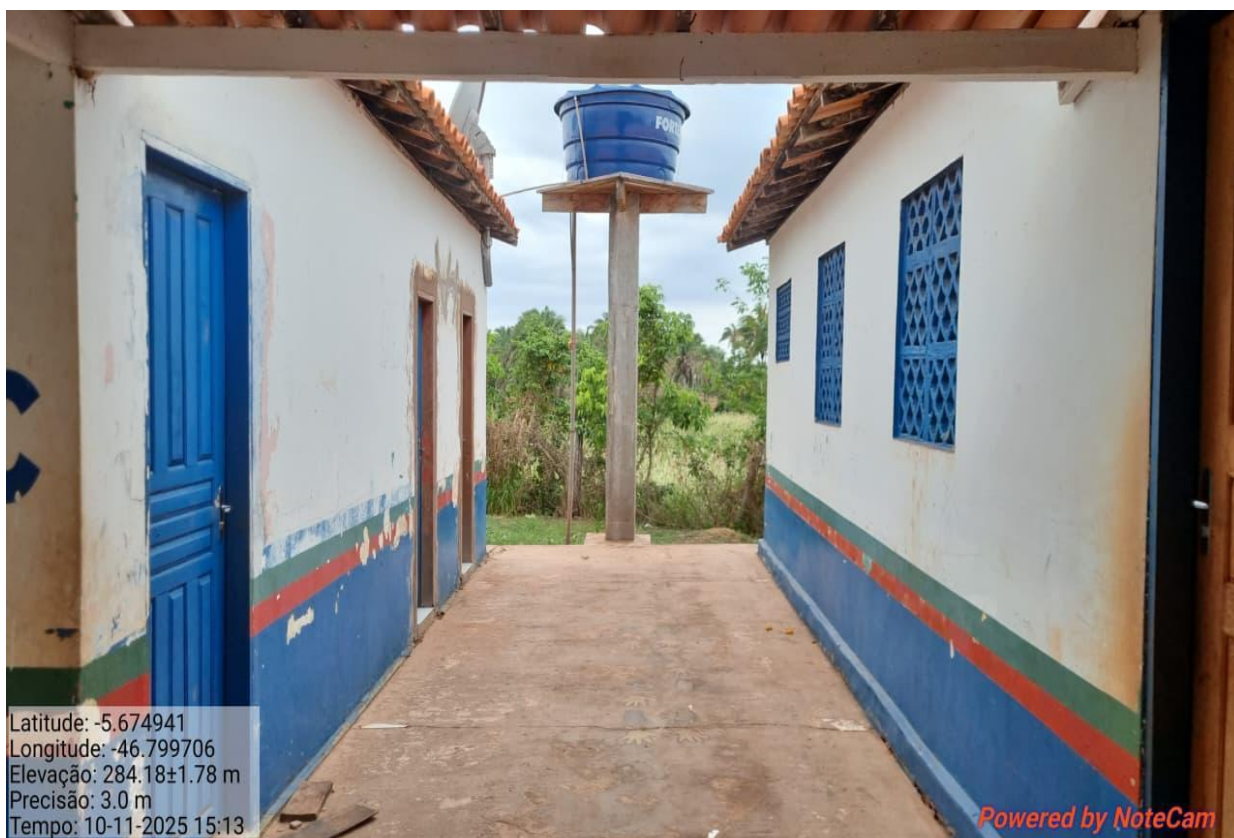
IMAGEM 04: MANUTENÇÃO DAS ESQUADRIAS, PISO CERÂMICO, PINTURA.
