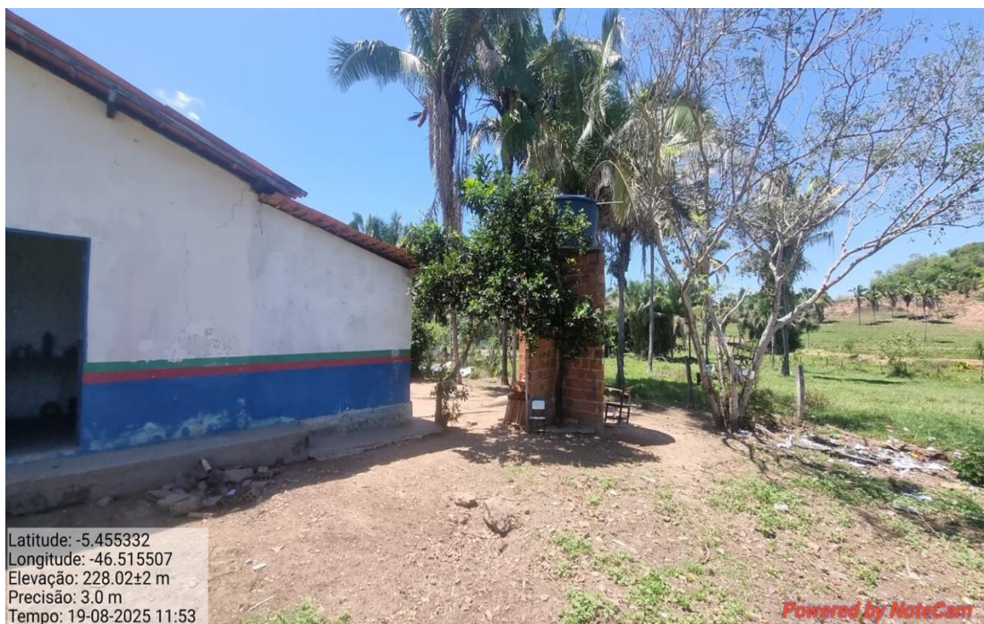
IMAGEM 02: FACHADA LATERAL DIREIRA ONDE SERÁ CONSTRUÍDO UMA SALA DE AULA.
