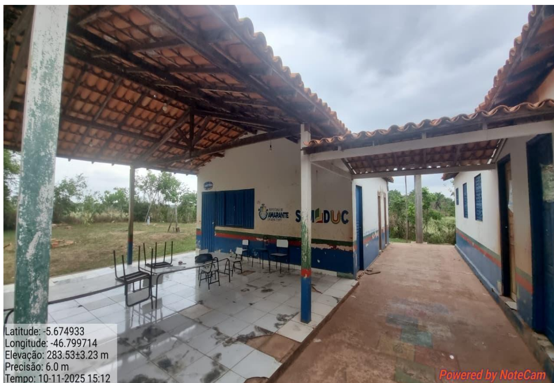
IMAGEM 01: CONSTRUÇÃO DE COBERTURA UNIFICANDO O TELHADO DO PÁTIO COM AS SALAS.
