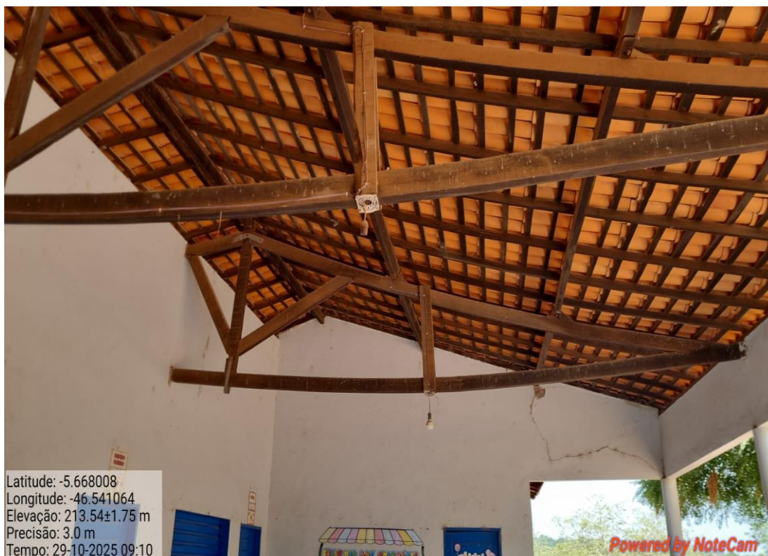
IMAGEM 06: TROCA DAS TESOURAS DE MADEIRA E RETELHAMENTO.
