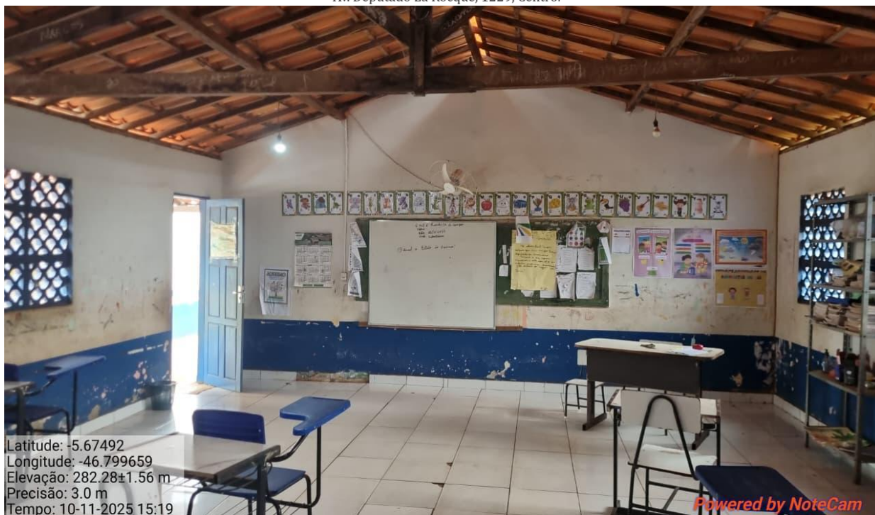
IMAGEM 03: TROCA DE PISO CERÂMICO, PINTURA E RETELHAMENTO.
