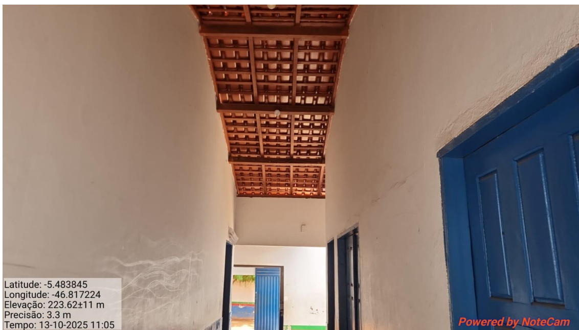
IMAGEM 19 - ÁREA CIRCULÇÃO COBERTA NO BLOCO 1 QUE SERÁ REFORMADO.
