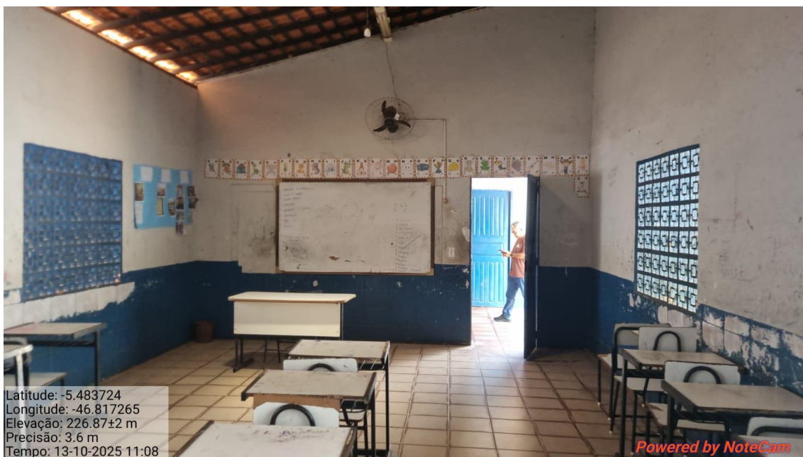
IMAGEM 24 – SALA DE AULA QUE RECEBERÁ NOVO PISO, NOVAS JANELAS E FORRO DE GESSO.
