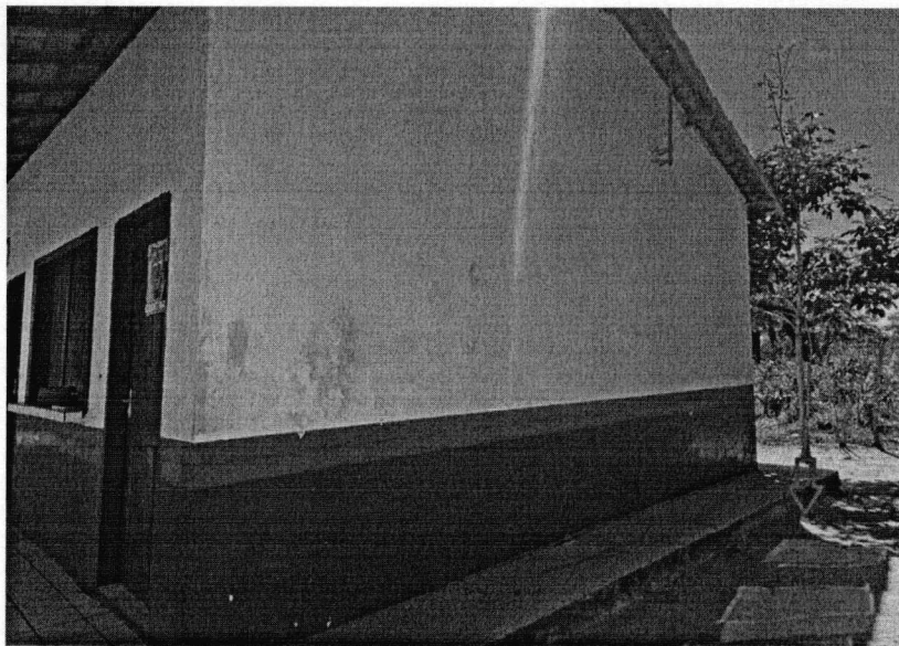
Imagem 02: Local onde será feito a ampliação.
