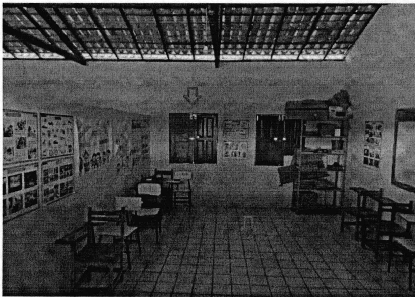
Imagem 01: Reparos nas Esquadrias, e troca de piso.
