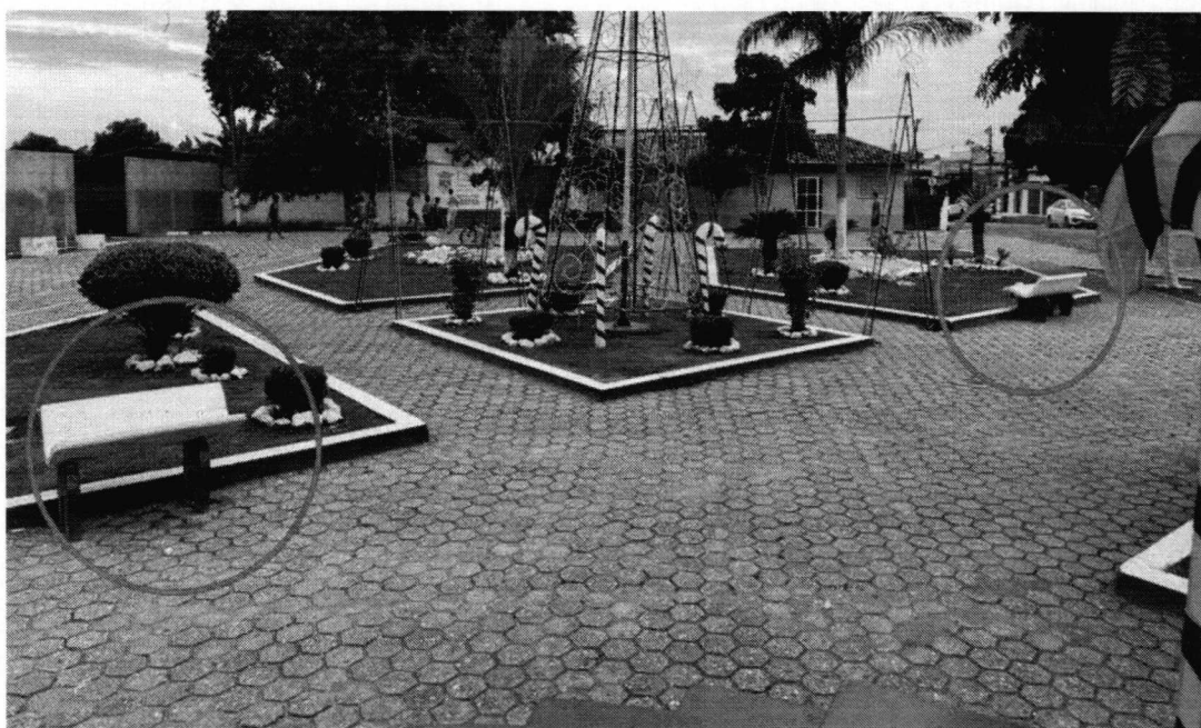
Imagem 05: Remoção de banco de concreto pré-moldado, substituição por Banco de concreto sem encosto, dimensão: 2,00x0,60m e bancos de madeira.
