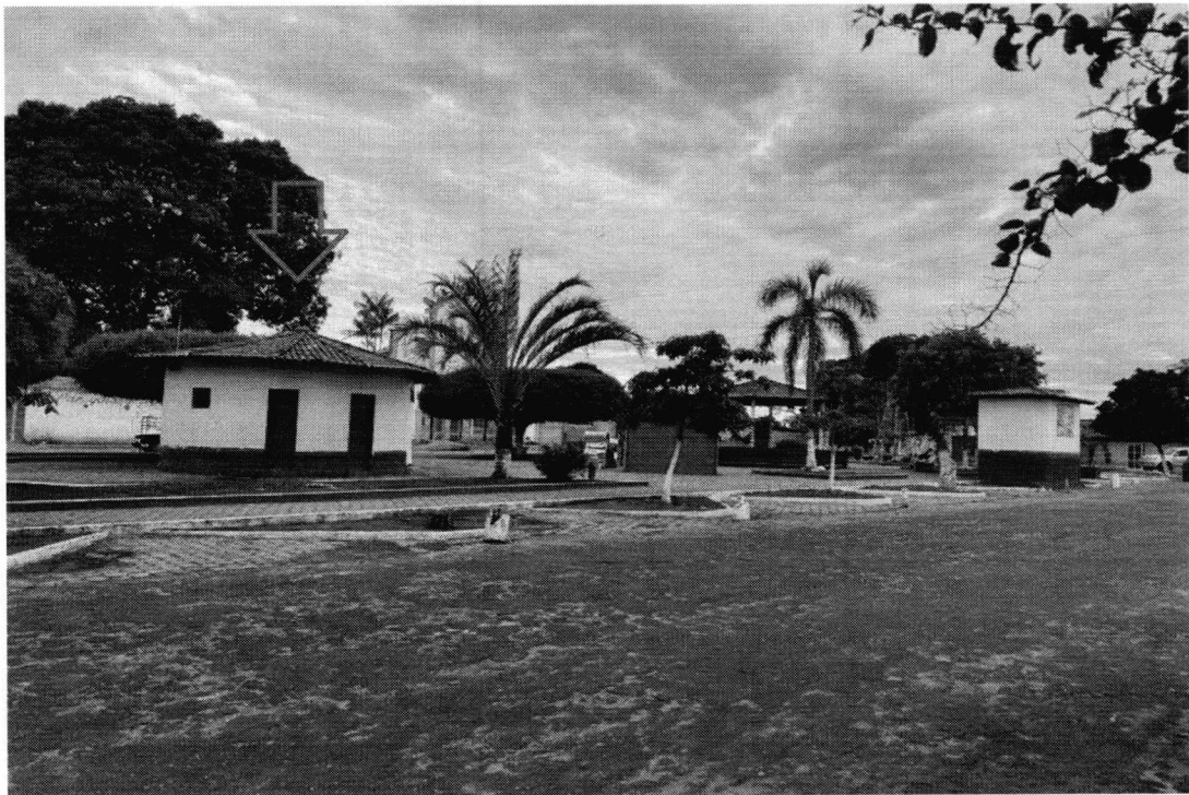
Imagem 03: Retelhamento das áreas dos quiosques.
