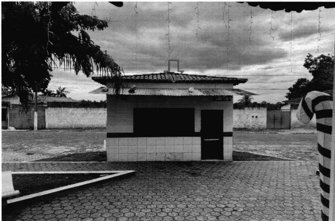
Imagem 01: Local onde será construído uma nova cobertura e novo revestimento cerâmico.
