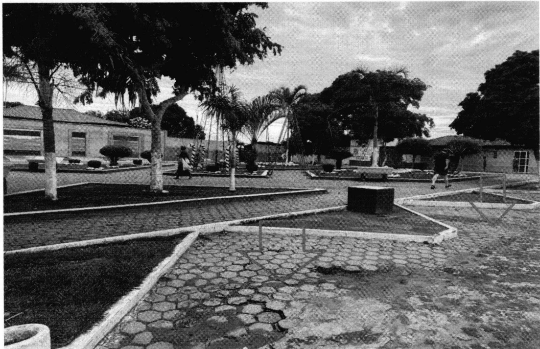
Imagem 04: Execução de pavimento em piso intertravado, com bloco sextavado de 25 x 25 cm, espessura 8 cm.
