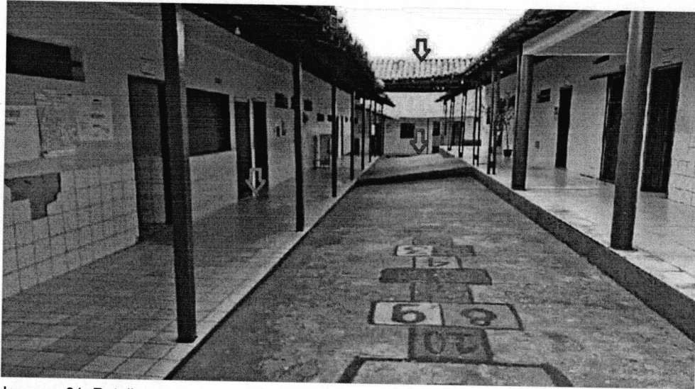
Imagem 01: Retelhamento , troca de piso e acessibilidade nas rampas .
