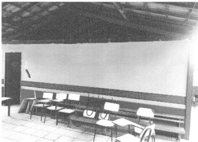
Parede a ser demolida, para aumentar a área do pátio.
