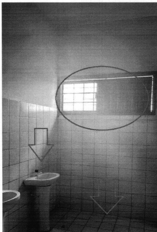
Imagem 09: Troca dos revestimentos dos banheiros, troca de piso e troca das esquadrias.
