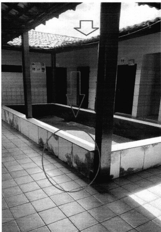
Imagem 08: Troca de piso, retalhamento.
