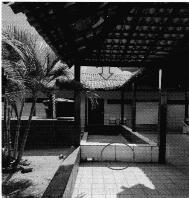
Imagem 04: Troca de revestimento e retelhamento.
