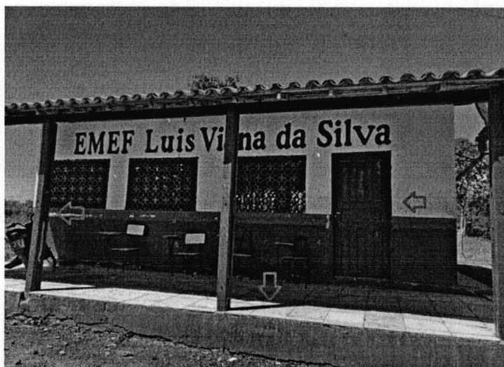
Imagem 01: Troca de piso, troca dos pilares de madeira por pilares de concreto e manutenção das esquadrias.
