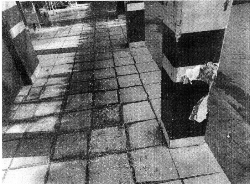
Recuperação de piso e troca de revestimento cerâmico
