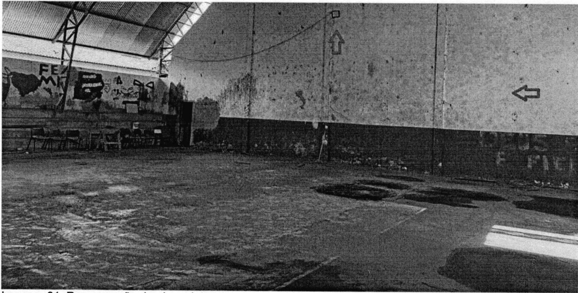
Imagem 01: Recuperação de piso, pintura e manutenção das instalações elétricas e iluminação.
