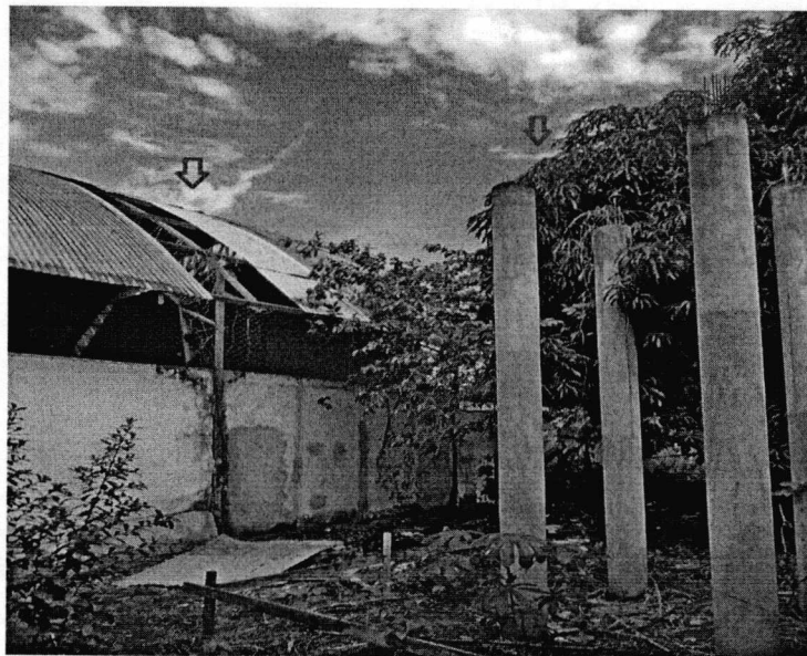
Imagem 02: Recuperação de telhado e estrutura da caixa d'água.
