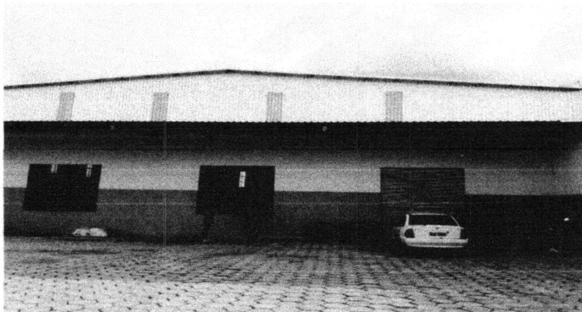
Imagem 01: Fachada Frontal do Galpão Comercial.
