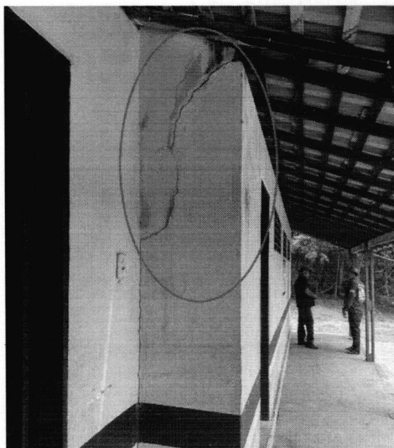
Imagem 04: Reparos da estrutura
