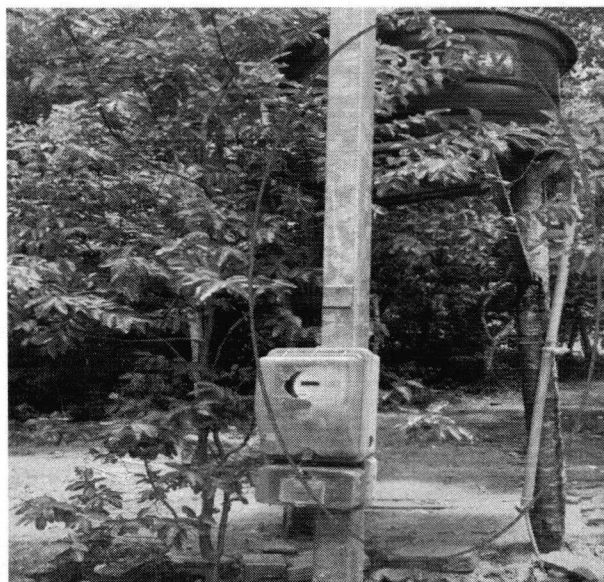
Imagem 08: Construção de uma nova estrutura para caixa d'água.
