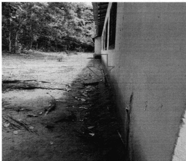
Imagem 02: Execução de calçada de proteção.
