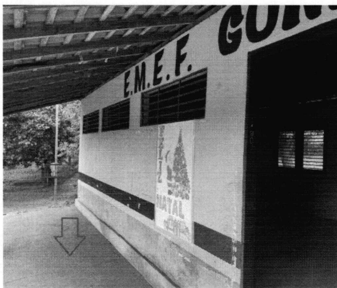
Imagem 01: Nova Pintura, troca de piso e reforma das esquadrias.
