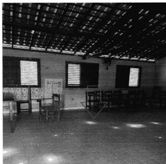
Imagem 05: Troca de piso
