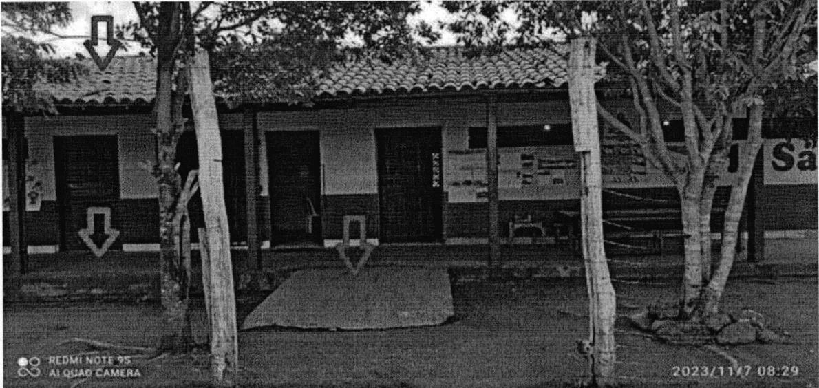
Imagem 01: Telhado necessitando de reparos, rampa sem acessibilidade, troca de piso.
