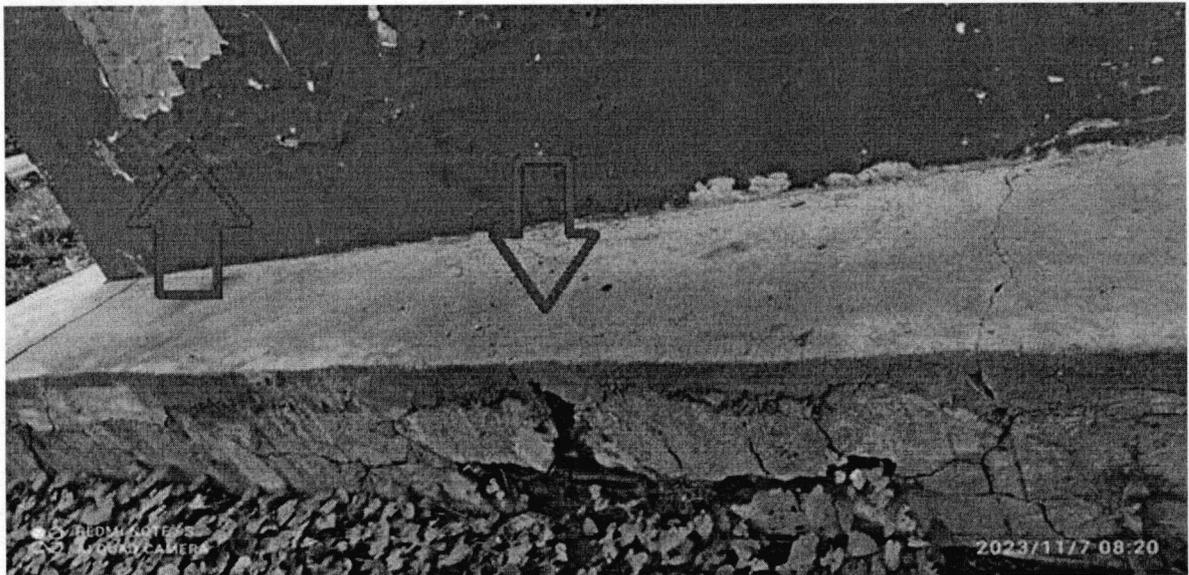
Imagem 02: Calçadas e pintura externa precisando de reparos.
