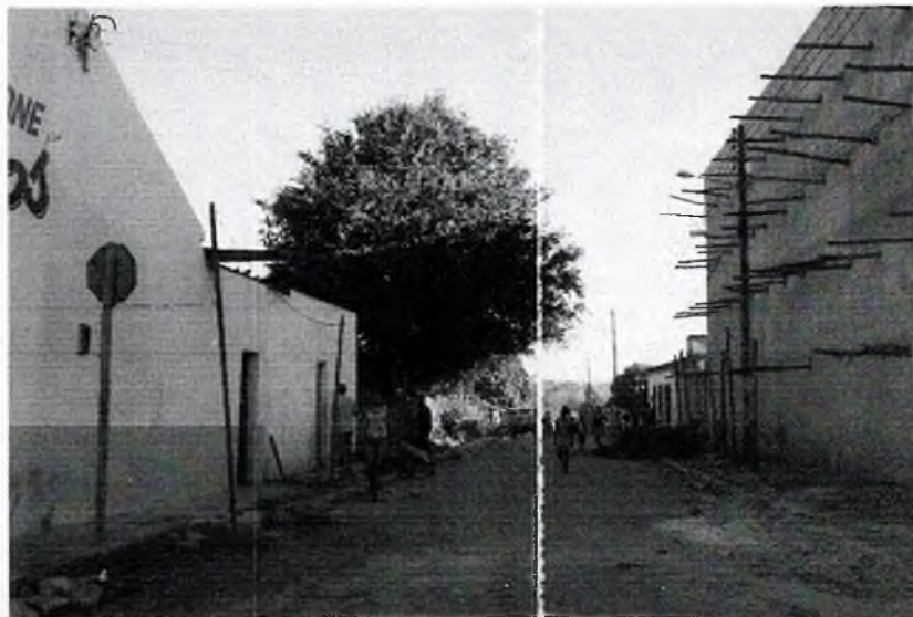
Fig. 9 Construções muito próximas das ruas
